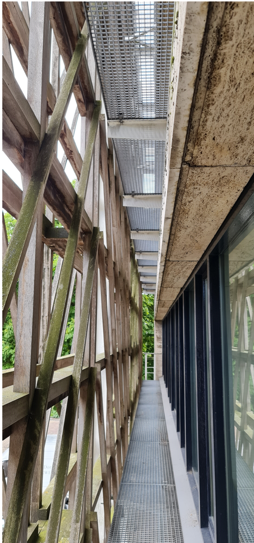
glazenwasbalkons aan de gevel aan de Zonneveldstraat
