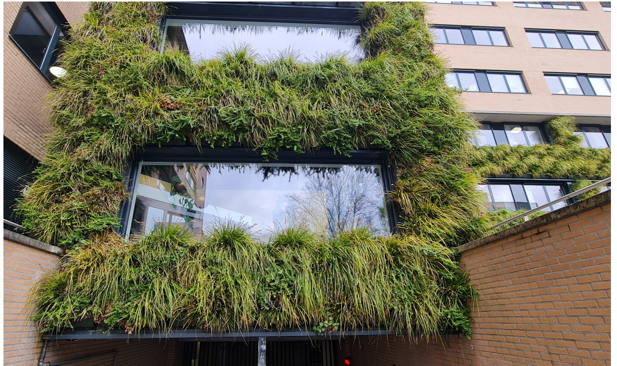
Referentie Modulogreen "groene gevel" achtergevel kantoorgebouw Schipholweg 103
