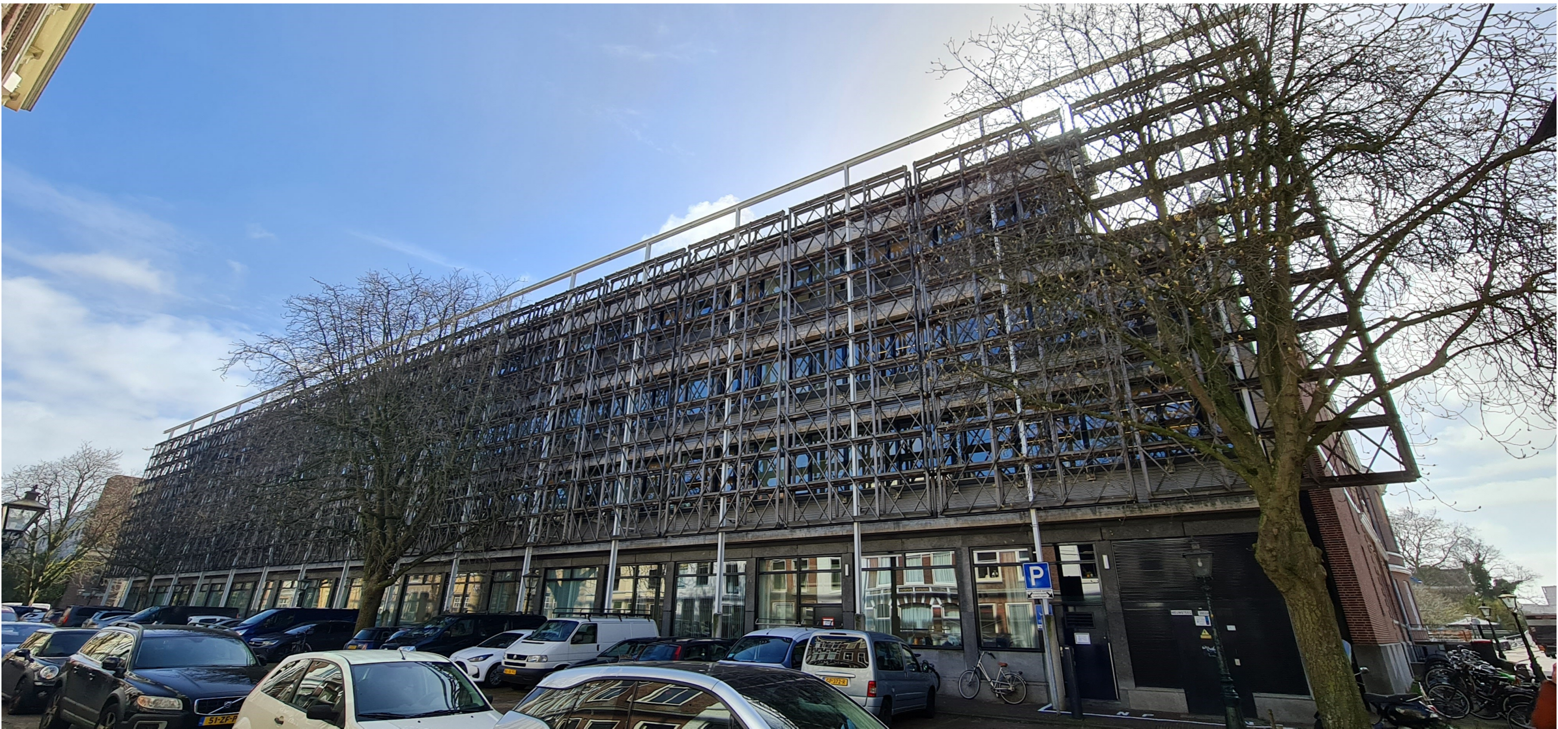
bestaande gevel aan de Zonneveldstraat
